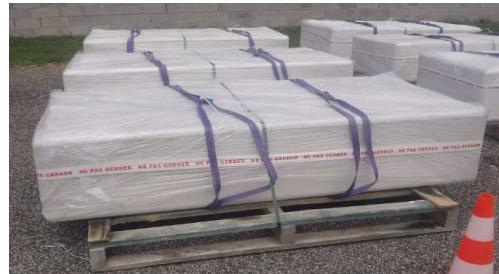
2 - Si la période de stockage sur chantier est importante, au-delà d'une semaine, nous conseillons de retirer le film de protection pour éviter les remontées de chaux dues à la condensation.
