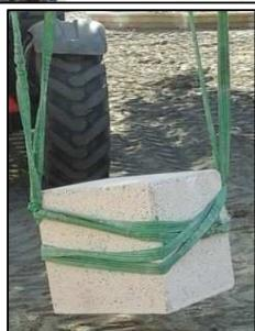
Si les banquettes sont posées alignées, nous prévoyons un jeu de 5 mm entre deux banquettes, pour éviter les épauffrures dues à la dilatation et à la pose. Une cale est scotchée verticalement pour cela.
