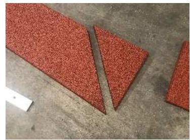
Tracer l'angle de découpe à 25 cm sur la partie **épaisse** de la dalle
