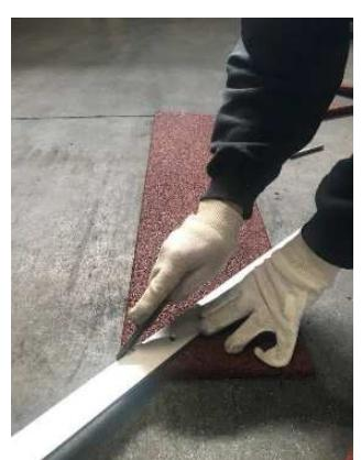
Tracer l'angle de découpe à 25 cm sur la partie **fine** (10 mm) de la dalle
