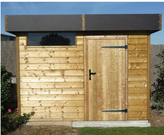
Abri toit plat + bandeau Fundermax®
