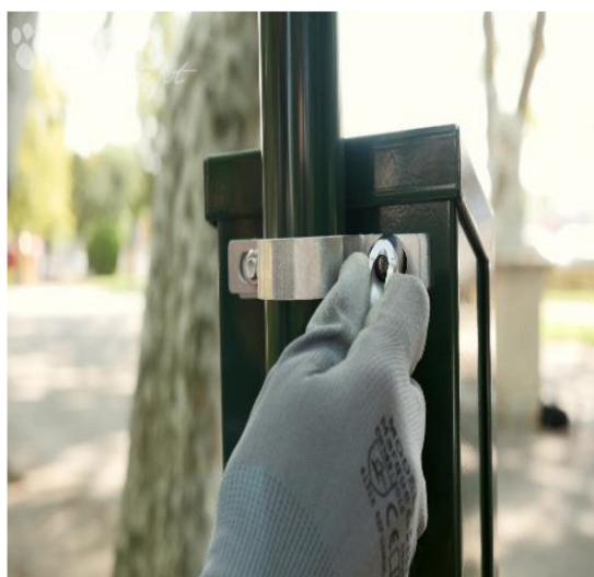
Installation du haut de mât et du cendrier sur le mât à l'aide des 2 colliers fournis
