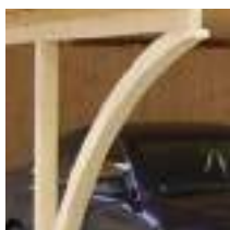
Arc en lamellé collé.
