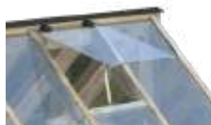
Ouverture automatique de la fenêtre.
